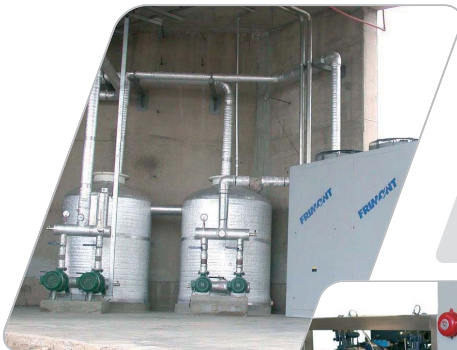
Mini sala de máquinas de 80 Cv con compresor a tornillos
