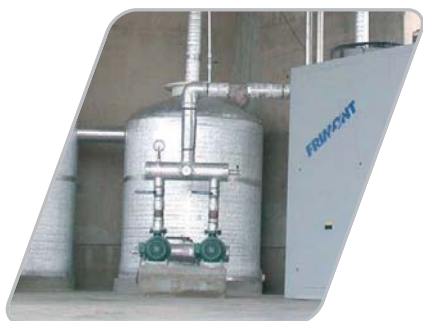
Mini sala de máquinas de 80 Cv con compresor a tornillos
